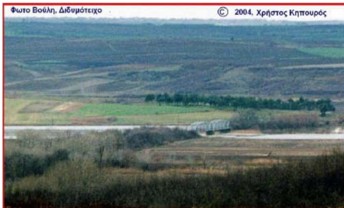
Σιδηροδρομική γέφυρα στον Έβρο
